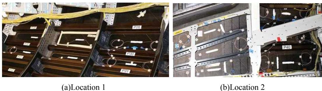
図2.3.4-1 計測線の設置状況
