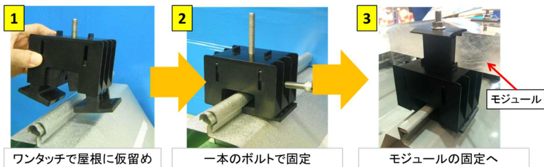
b) 開発した第二世代施工簡便化据付部品の取付けの様子
