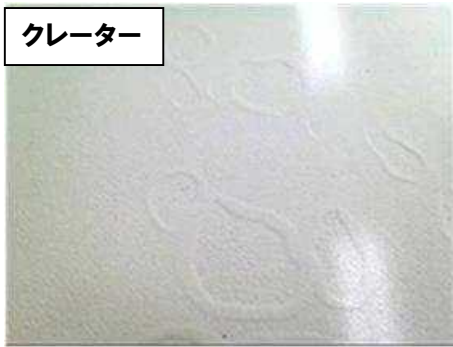
図Ⅲ-2-(へ)-G-1(23) EPDM 封止材にできたクレーター
