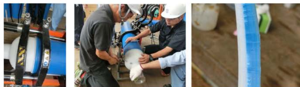
写真左より、①溶着した鏡部とPE管の溶着部に出現した凸部の写真。②その凸部をカキ取っている所の写真。③カキ取った溶着部の端片。この端面の、信頼性評価は、スライド# 11を参照ください
