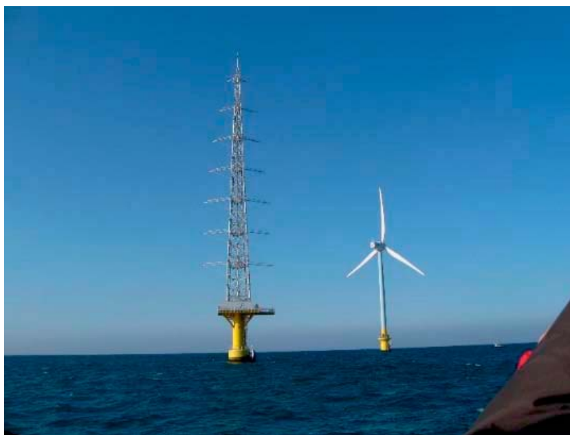
図 2.3.2-5 着床式洋上風力発電実証研究施設(銚子沖)
