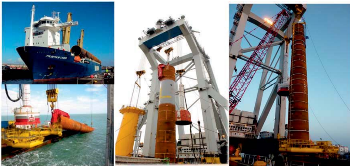
図 3.7.2-6 モノパイルの運搬状況(Ballast Nedam, 2011)
