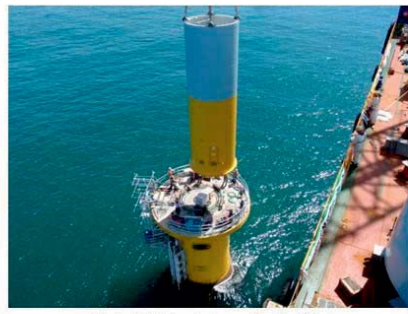
【1節タワー据付】
