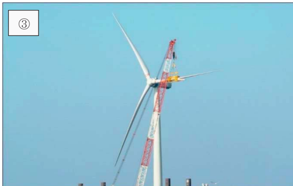
①ブレード No.1 据付 ②ブレード No.2 据付 ③ブレード No.3 据付 ④ブレード据付完了 図 3. 7. 2-66b ブレードの据付け状況 (電源開発資料)
