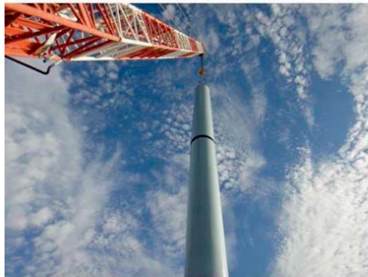
【4節タワー据付】
