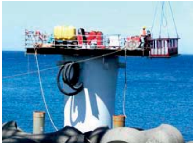
図3.4.5-3 モノパイル式の概念図(青木, 2009)と写真(小松崎都市開発, 提供)
