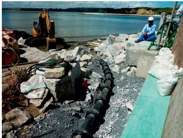
図 3.7.2-88 陸上部のケーブルの防護状況(東京電力・鹿島建設資料)
