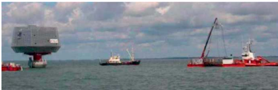
図 3.7.2-85 海底ケーブルの敷設状況 (日本産業機械工業会, 2010)
