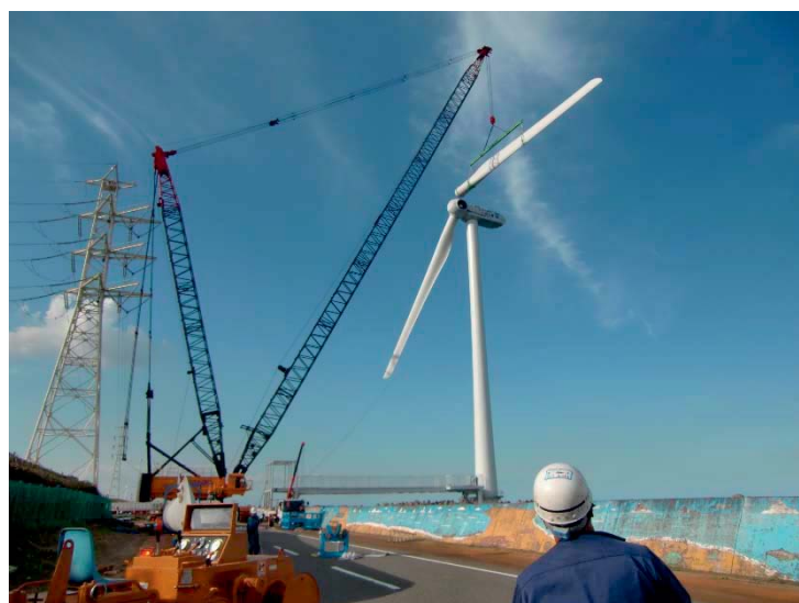
上左図：モノパイルへのボルトタワーの接続 上右図：ナセルへのハブの据付け 下中央図：ブレードの据付け
