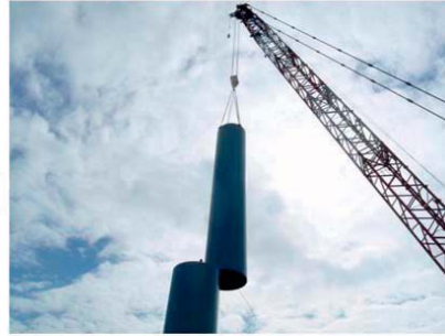
【3節タワー据付】
