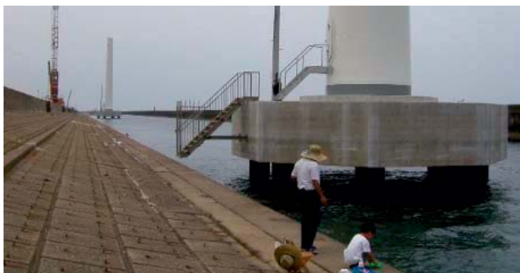
図 3.4.5-2 ドルフィン式支持構物(上図:瀬棚港/せたな町 HP, 下図:酒田港/windpower HP)
