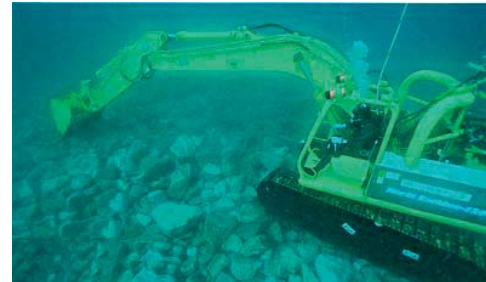
水中バックホウによる 均し作業のイメージ
