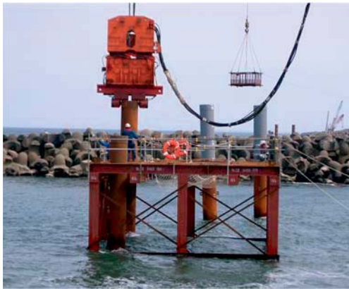
図 3.7.2-11 導杭打設状況(岡野, 2010)
