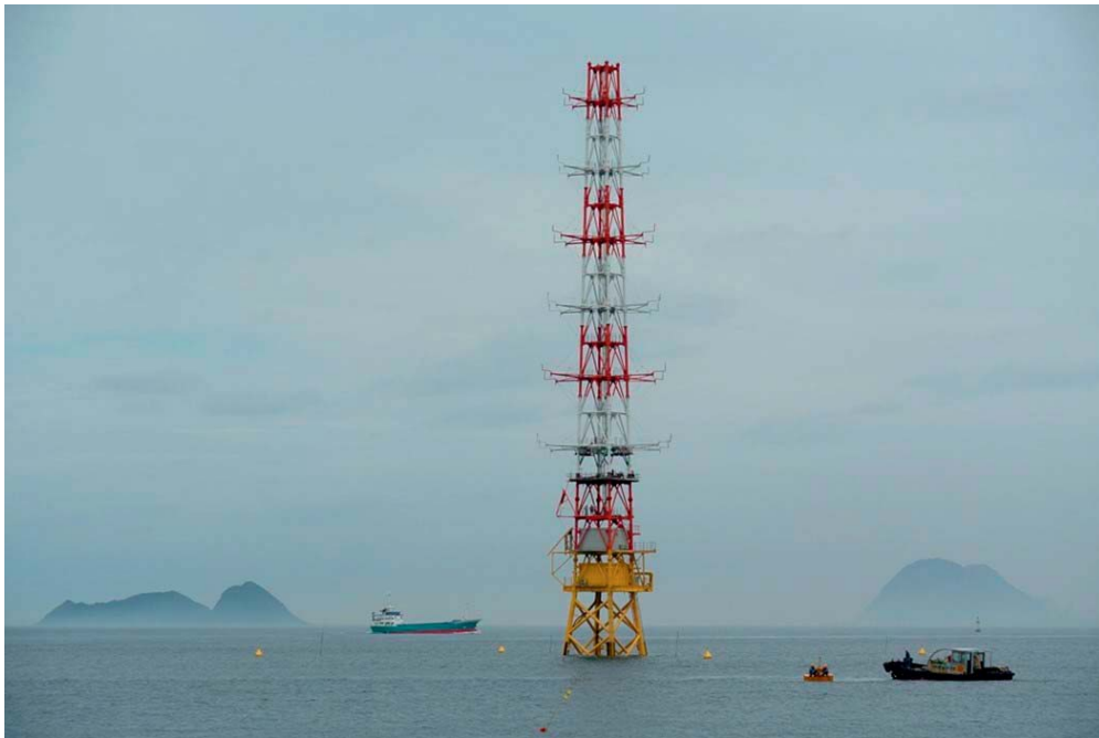
観測塔(2)の作業期間：2012年6月28日～6月30日,稼働率 33.3%(1日/3日)
