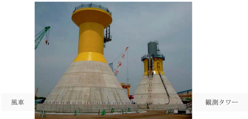
図 3.4.5-4 銚子沖サイトにおける重力式支持構造物(東京電力・東京大学資料)
