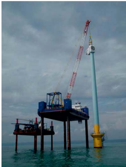
【据付作業状況全景】
