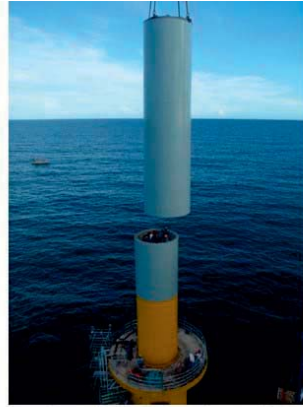
【2節タワー据付】
