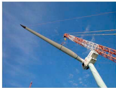
【ブレード据付】
