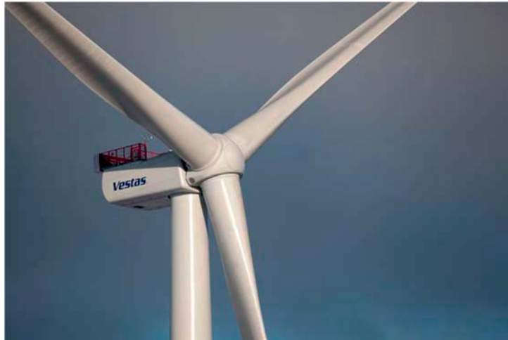
図-2 V164-7 Vestas 8.0MW (同期式(増速機+永久磁石方式) : Vestas HP)
