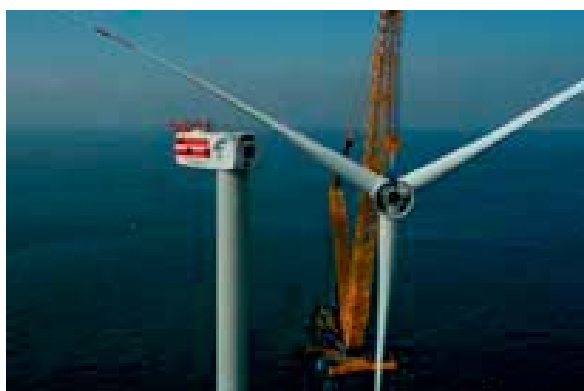
図 3.7.2-48 Thornton Bank I における風車の設置工事
