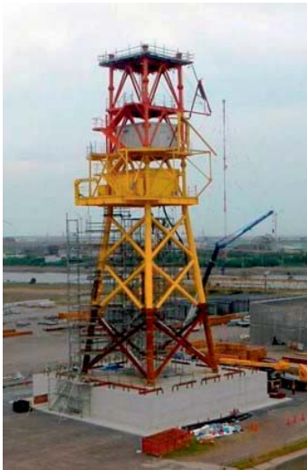
図 3.7.2-20 北九州市沖の支持構造物(ハイブリッド重力式構造:電源開発資料)
