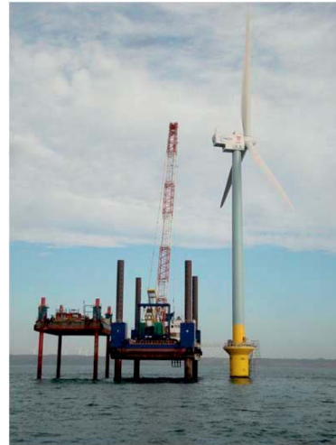
【風車部材据付完了】
