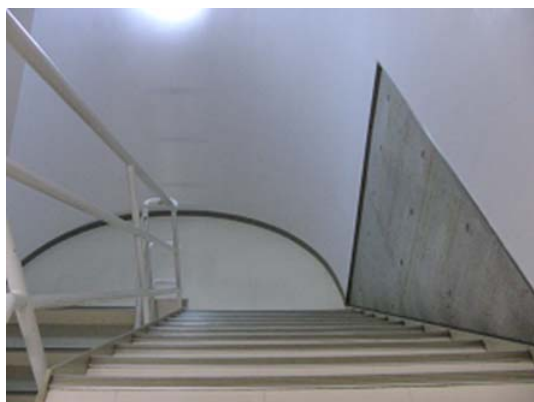
a) 室内階段 カラー写真
