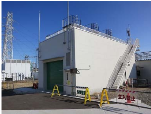
冷却システム建屋
