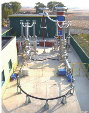
275kV高電圧ケーブル課通電試験 (瀋陽古河電纜有限公司にて実施)
