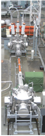
66kV大電流ケーブル課通電試験 (住友電気工業(株)にて実施)
