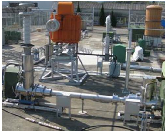
図 2.2.1-92 中間接続部の課電試験風景
