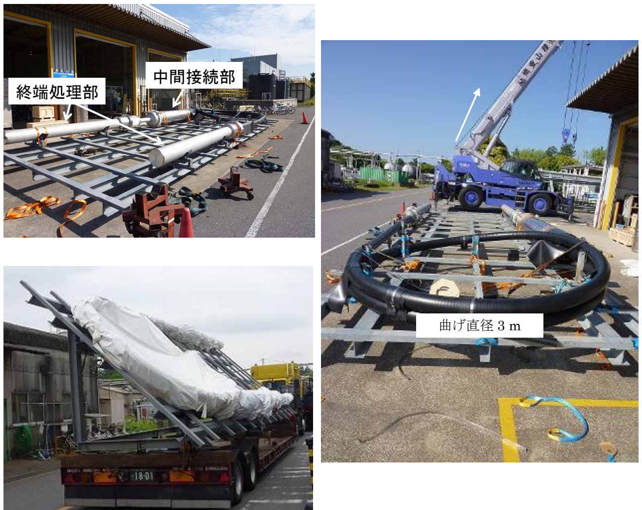
図 2.2.4-7 検証用超電導ケーブルの出荷（千葉 市原市）
