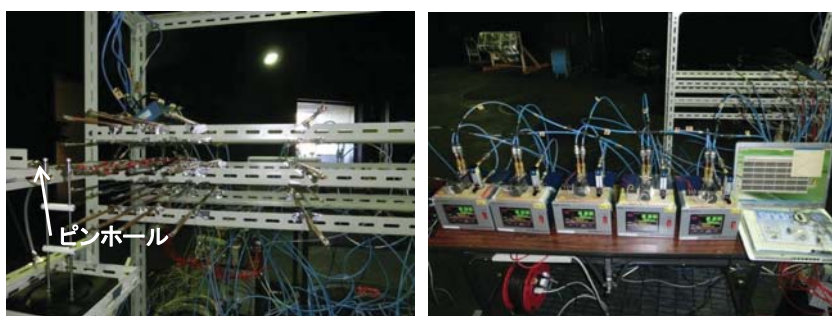
冷媒濃度計測装置
