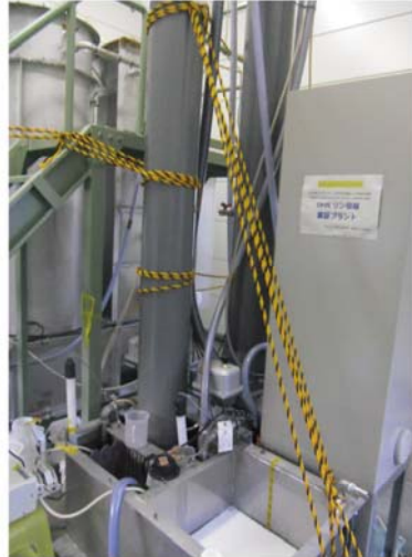
循環DHSリアクター設置状況
