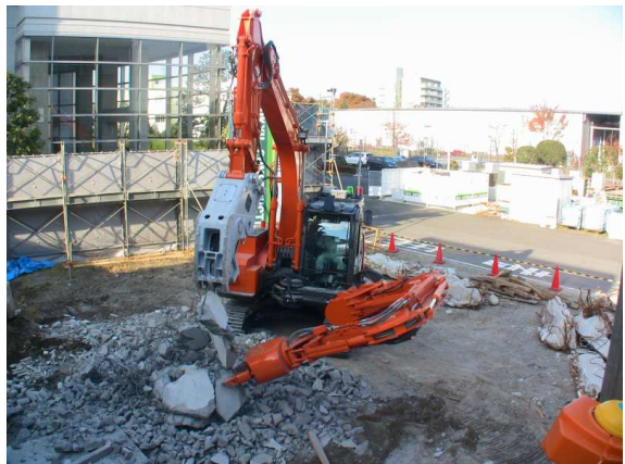
図 27 副腕での鉄筋切断
