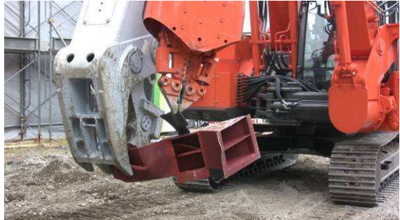
図 29 ゴム部材の引き剥がし
