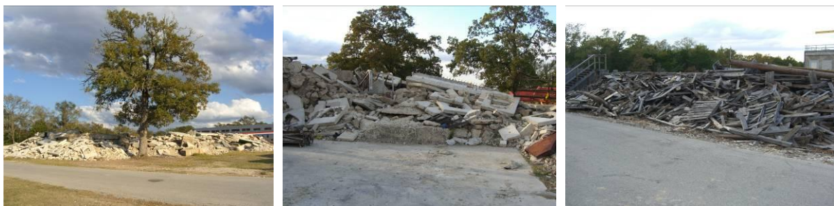
(a) 鉄筋コンクリート瓦礫 1 (b) 鉄筋コンクリート瓦礫 2 (c) 木造瓦礫 (10mのみ)
