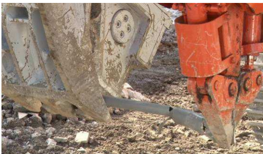
図 28 パイプ断熱材除 (拡大)
