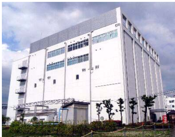
IV-1-II-⑤-(1)-図 1 LPP 光源の工場予定のコマツ湘南工場内 T 棟
