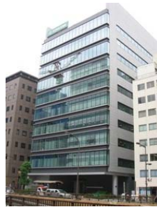
図IV.3-4 専用部清掃ロボット導入予定のオフィスビル
