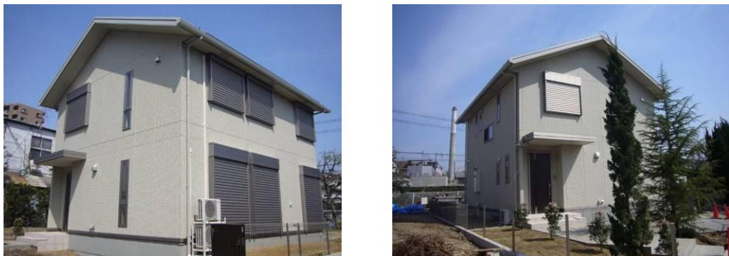
図3 実証住宅の外観
