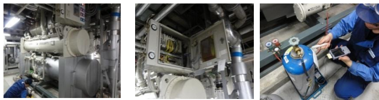
機器外観 ICタグは操作盤裏面に貼付 ICタグボンベ読取り
