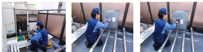
機器外観 ICタグは外板裏面に貼付 ICタグ機器書込み
