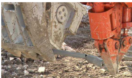
図 28 パイプ断熱材除 (拡大)
