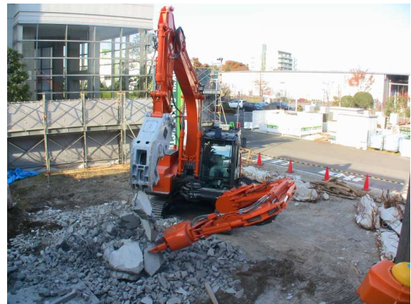
図 27 副腕での鉄筋切断
