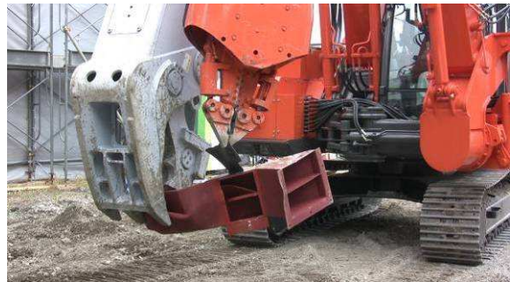
図 29 ゴム部材の引き剥がし
