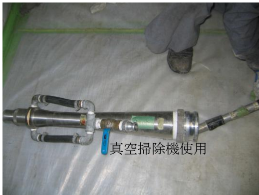
写真 7-15 バキューム装置（清掃後）
