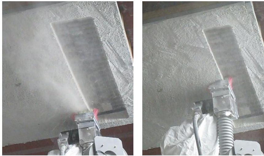
(a) 剥離開始時の粉塵発生 (b) 一般部剥離時の状況
