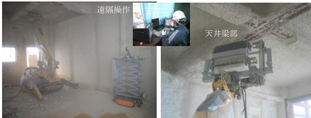
写真 6-12 遠隔操作による除去実験状況
