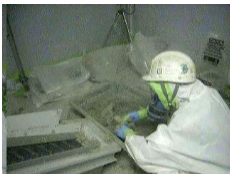
写真 7-6 コンベア装置にアスベスト廃棄物を投入
