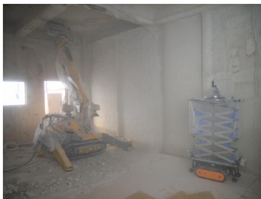
写真 5-4 ロボット除去作業場内
