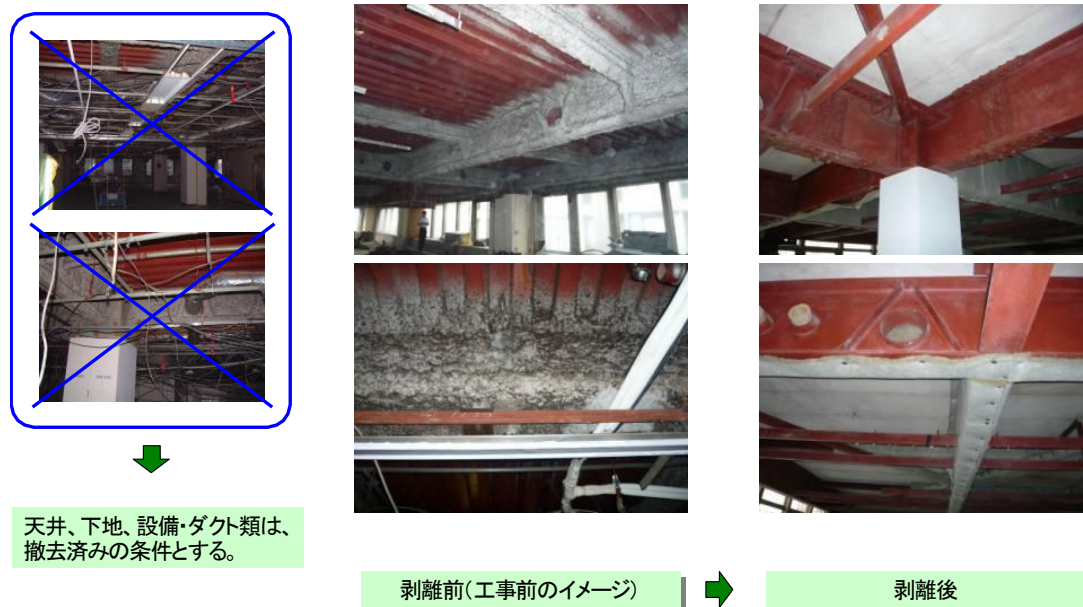
図 6.2-2 現場の状況・イメージ
