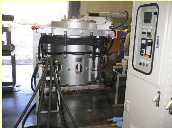
150kW誘導加熱溶融炉
