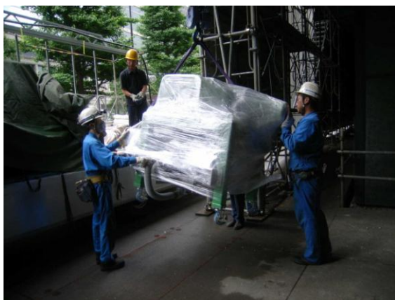
写真 7-2 システム装置類積み下ろし
