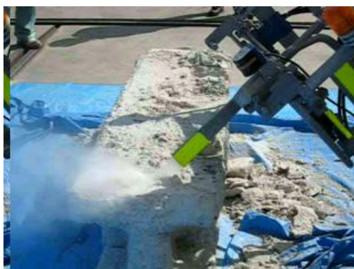
写真 6-3 高圧水噴射による除去状況
