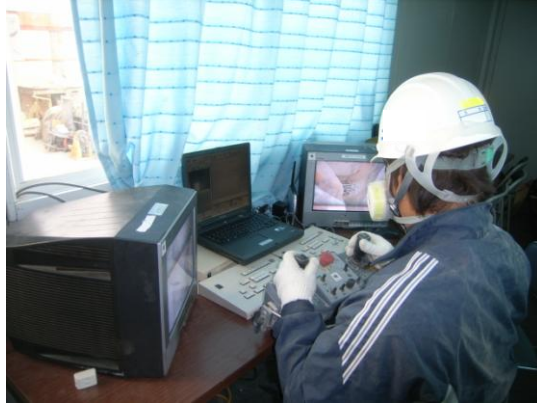
写真 5-2 ロボット遠隔操作（手元作業）
