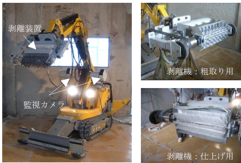
写真 2-1 剥離用アタッチメント（粗取り用/仕上げ用）
