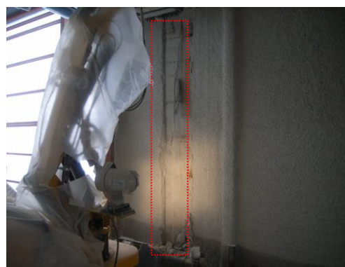
写真 6-8 模擬吹付けアスベスト除去実験状況 写真 6-9 除去後の壁面
