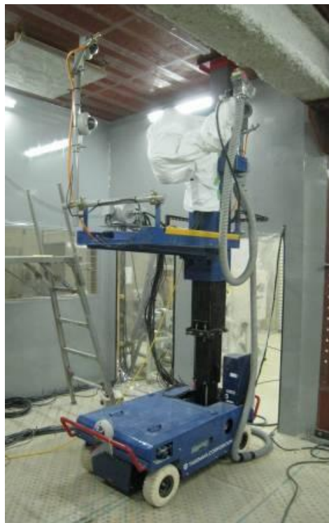
図 5.3-1 剥離実証実験状況
