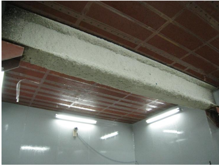
図 5.2-4 実大鉄骨梁モックアップ
