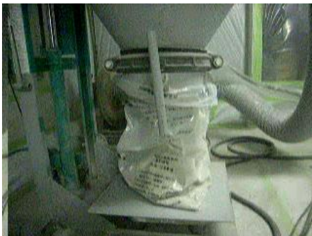
写真 7-9 破碎後のアスベスト廃棄物の袋詰め
