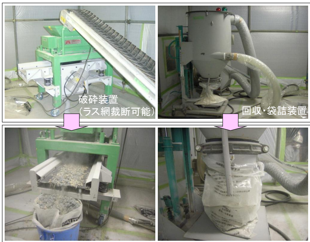
写真 7-5 システム装置類の設置状況
