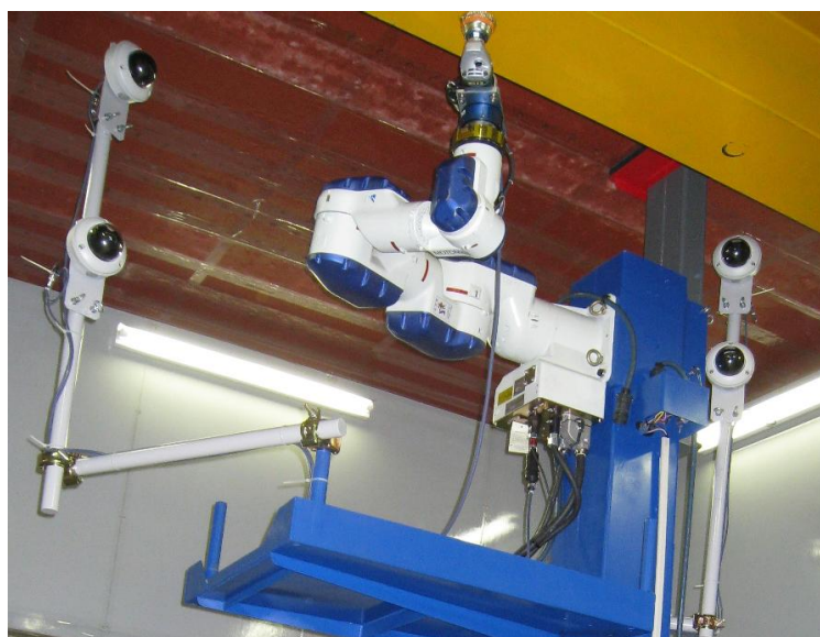
図 2.2-12 剥離作業監視カメラ取付け状況
