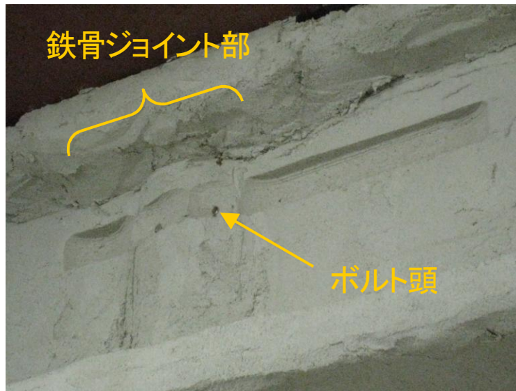
図 5.3-9 障害物回避機能を用いた剥離実験
