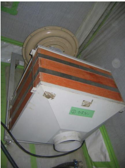
写真 7-18 排気浄化装置 (清掃後)
