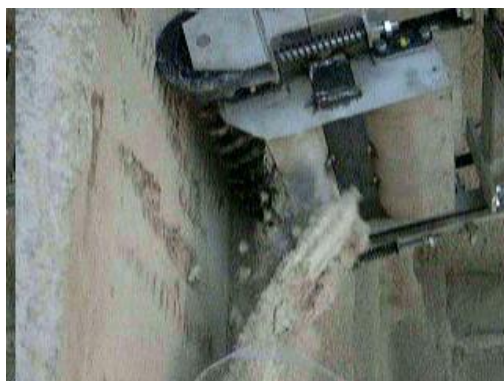
写真 6-8 模擬吹付けアスベスト除去実験状況 写真 6-9 除去後の壁面
