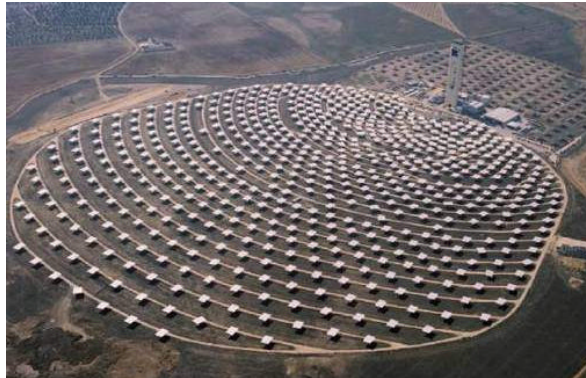
図表 5.6 PS10 太陽熱発電プラント
