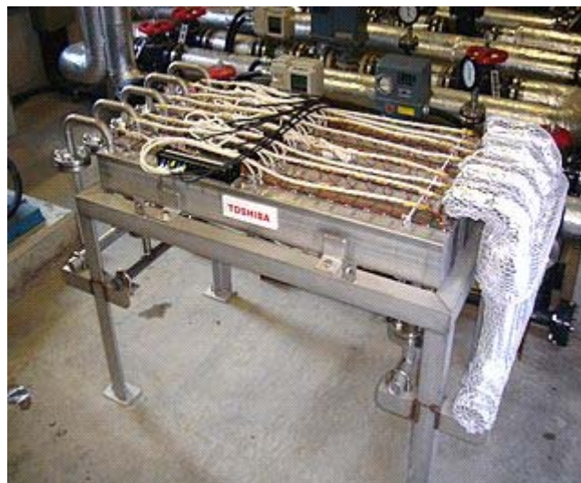
図表 熱電変換発電システム
