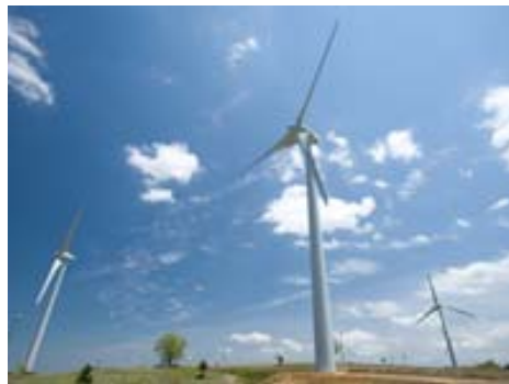
図表 3.65 J-POWER の郡山布引高原風力発電所
