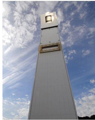
図表 5.28 Jülich 実証プラント（タワー部分）
