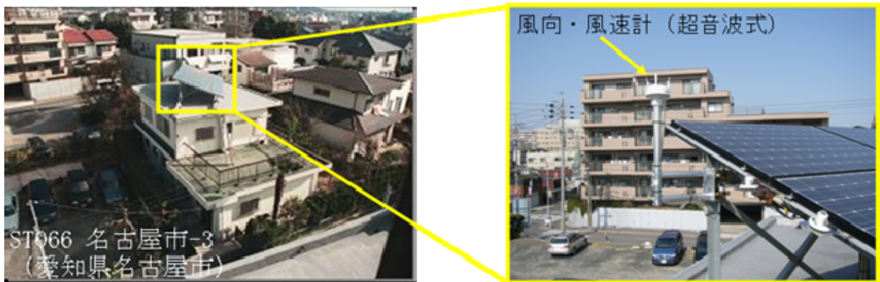
図 2.2.2-8 風向・風速計の設置
