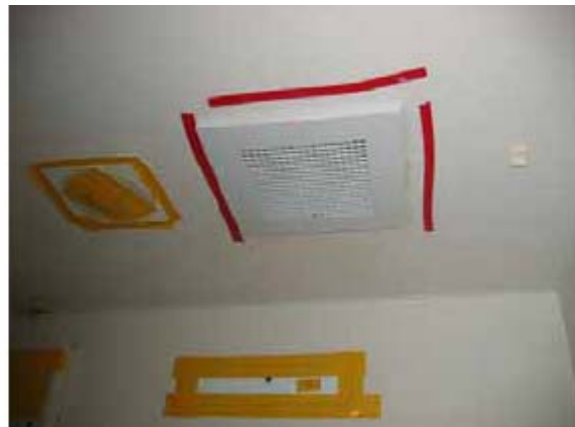
図Ⅲ-2-2-28 リビングへの補助排気ファン増設
