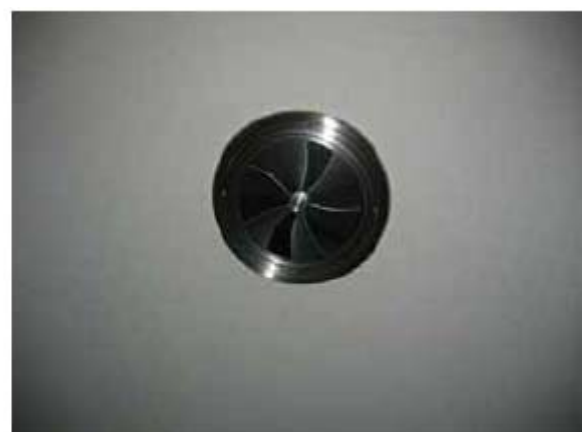
図Ⅲ-2-2-29 1階廊下（左写真）、2階納戸（右写真）への補助排気ファン増設
