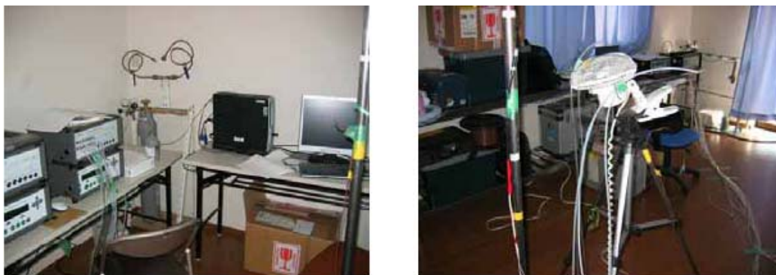
図Ⅲ-2-2-37 マルチガスモニタを用いた一定濃度法測定状況及びリビングにおけるドーザー、サンプラーチューブ及びトレーサーガス攪拌用ファン設置状況
