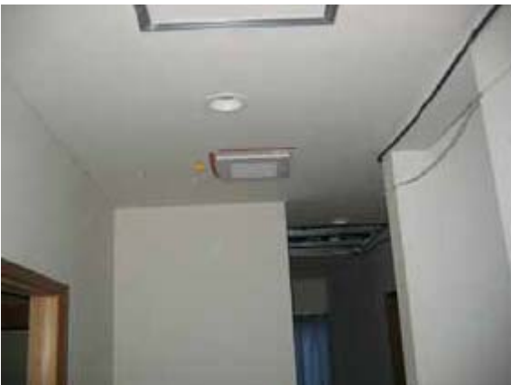
図Ⅲ-2-2-28 リビングへの補助排気ファン増設
