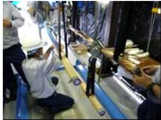
(b) 保護層、Cu シールド層の除去
