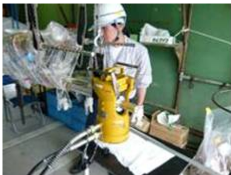
(e) 導体接続金具の圧縮
