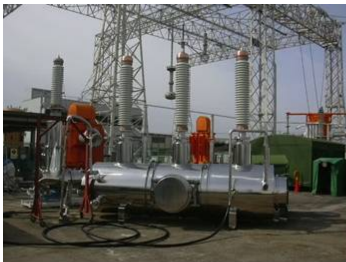
図 2.1.4-15 終端接続部単体試験状況
