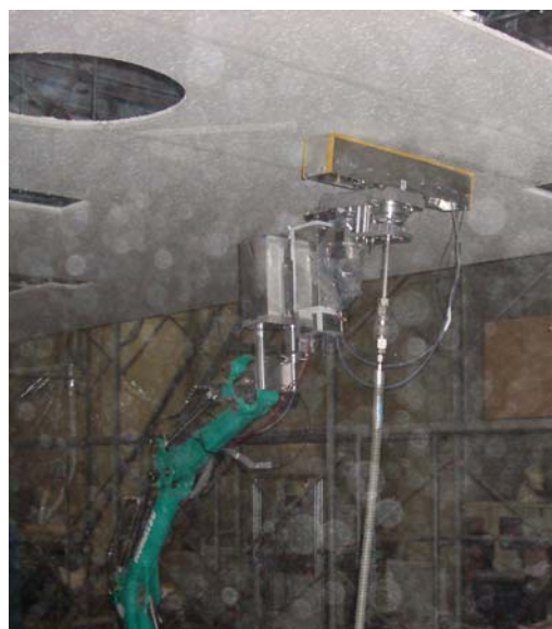
図 2-4 天井ボード切断状況
