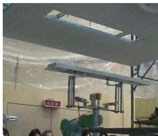
図 3-4 蛍光灯パネルの回収
