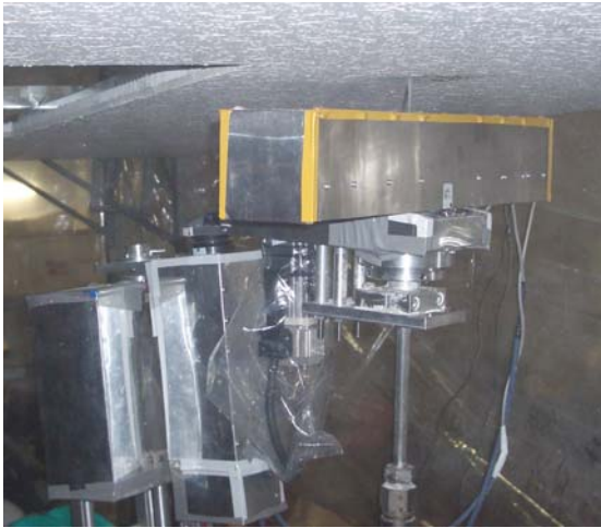
図 3-8 ウォータージェット切断状況
