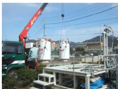
容器据え付けの様子
