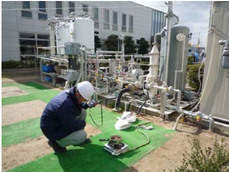
屋外でのコンロ燃焼試験
