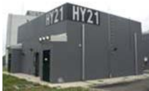
曝露棟(HY21棟)
