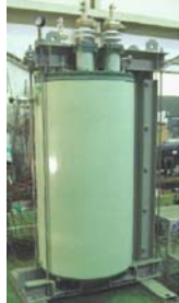
400kVA短絡モデル変圧器
