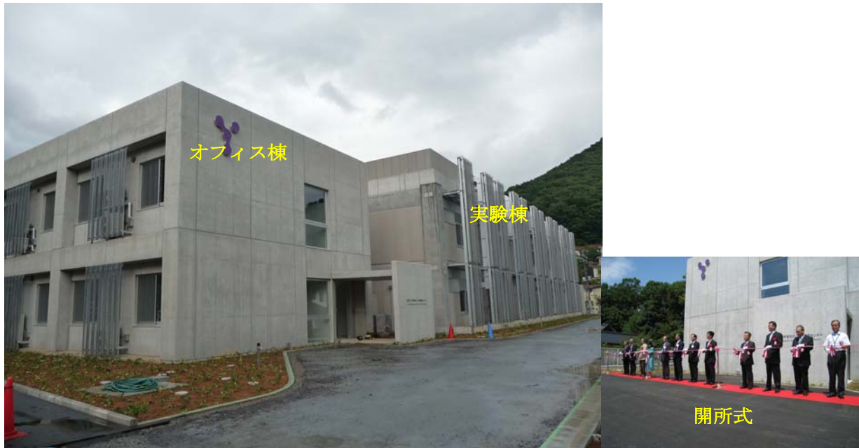
図II-6 山梨大学 燃料電池ナノ材料研究センター
