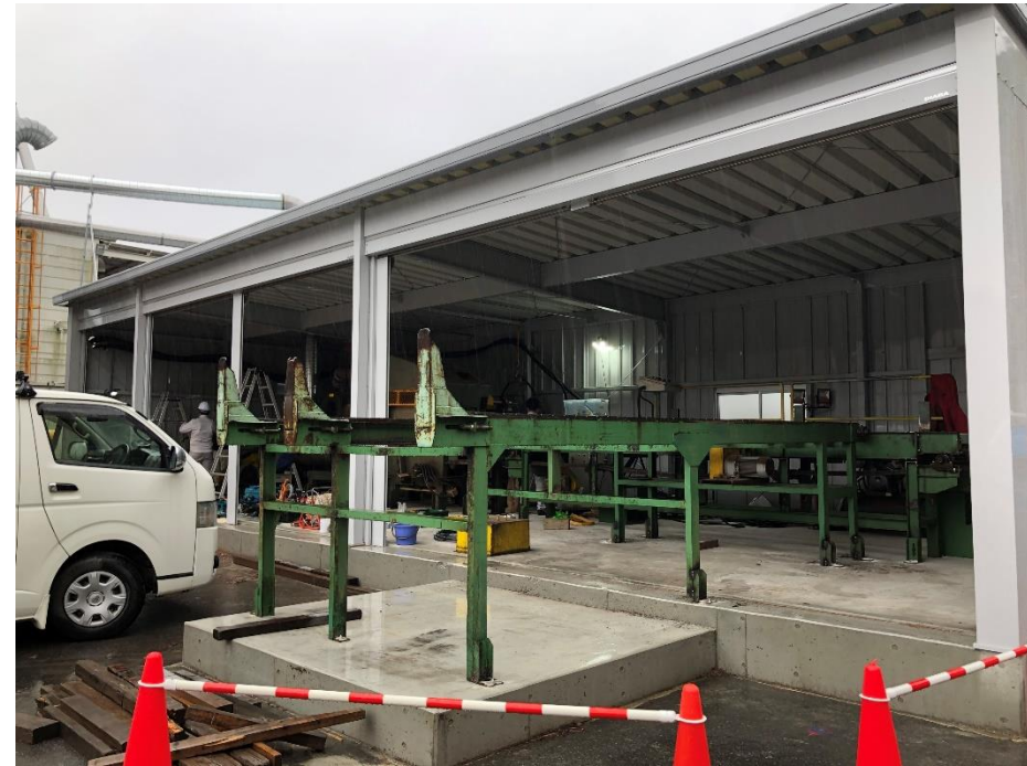
②既設おが粉製造機の移設 (12/13)
