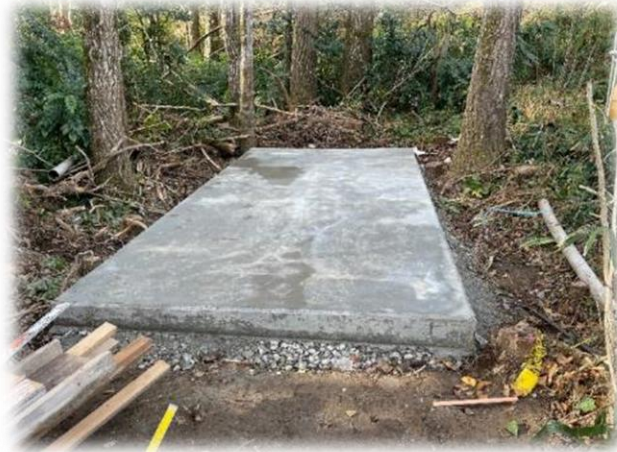
貯水タンク基礎工事 (2023年12月18日)
