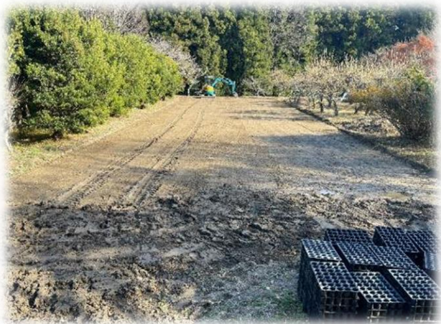
整地工事 (2023年12月14日)
