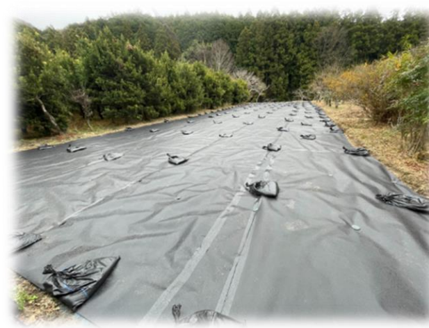
整地工事 (2023年12月19日)
