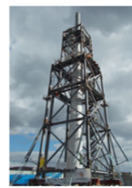
タワージャッキダウン 解体工法
