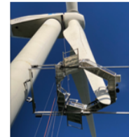
ブレード補修ゴンドラ
