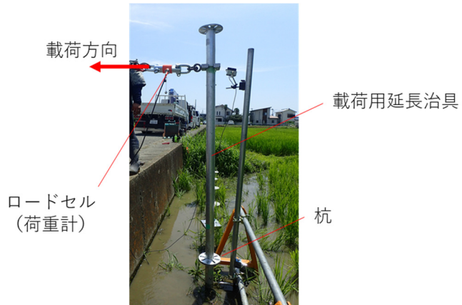
(c) 水平荷重試験の状況
