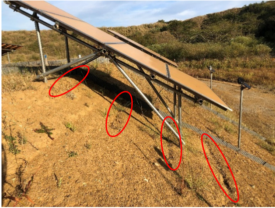
図 5-5 30 度裸地 架台（長辺傾き 3 度）
