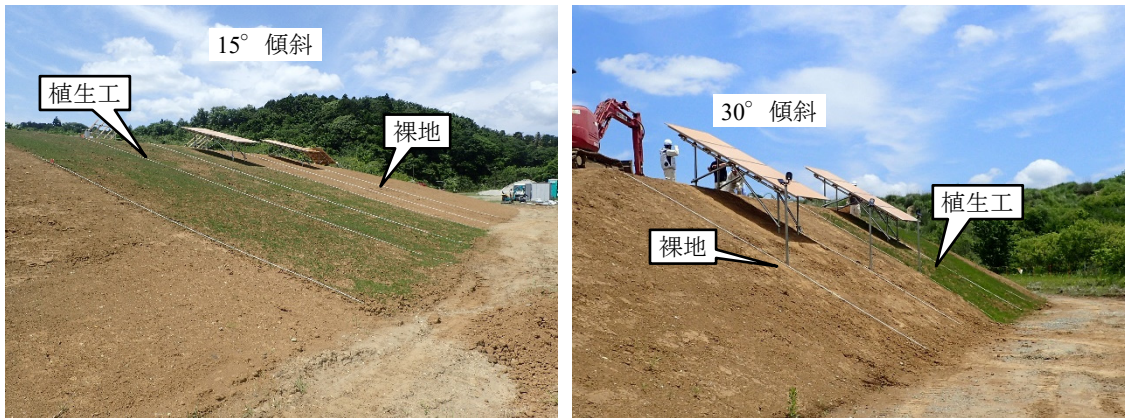
図 4-2 検証対象の傾斜地状況
