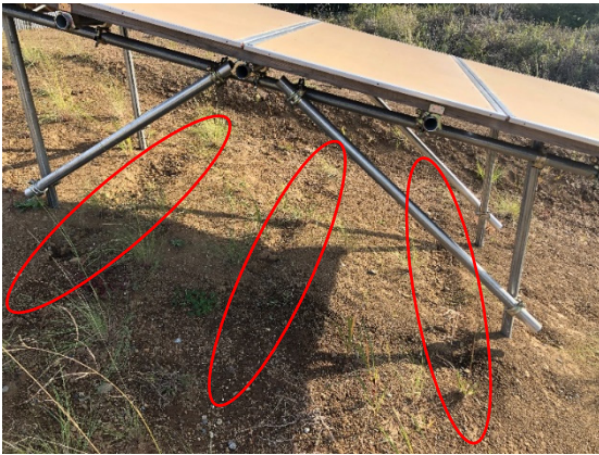
図 5-8 水路付き架台（左：15 度傾斜、右：30 度傾斜）
