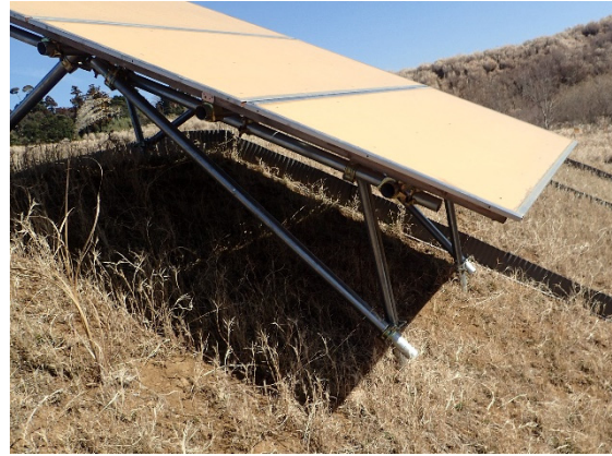
図 5-6 30 度植生工 架台（長辺傾き 3 度）
