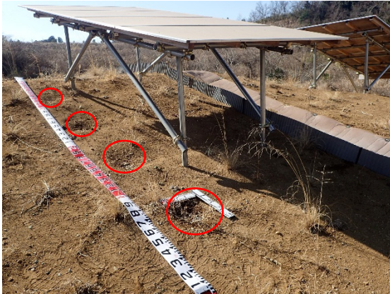
図 5-1 15 度裸地 架台（長辺傾き 3 度）
