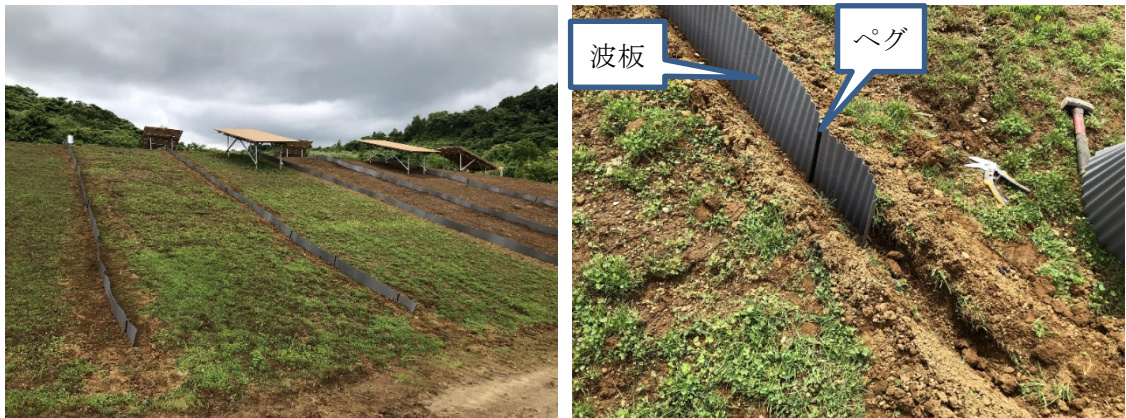
図 4-3 セパレータの設置状況
