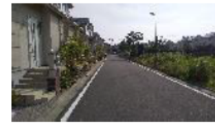
路側帯の設置された道路
