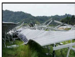
<風水害による破損>
