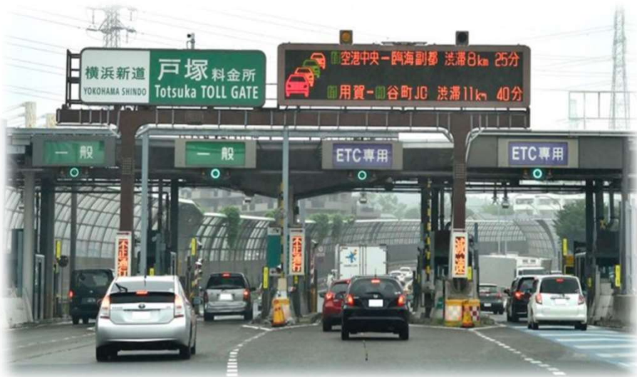
高速道路入口ゲート(料金所)
