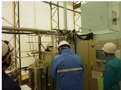
図 3. 2. 2. 3-15 一貫製造プロセス全体の確認および試運転
