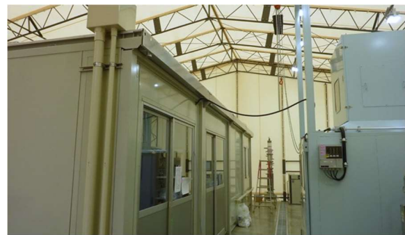
図 3.2.2.3-10 テント内プレハブ研究室
