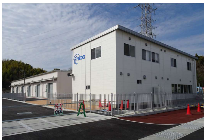
図 3.2.1.2-9 共用棟の竣工状況(2022年3月29日)
