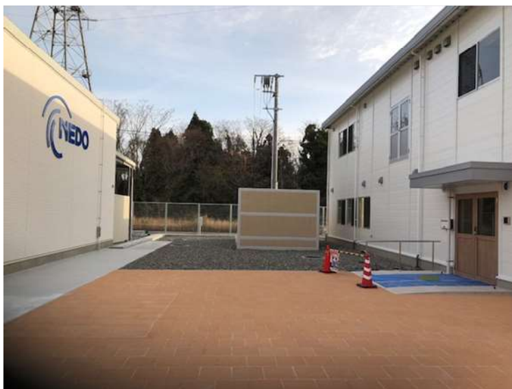
図 3.2.1.2-14 基礎研究・先導研究拠点外構部の竣工状況(共用棟と研究棟間のインターロッキングブロック)(2022年3月23日)
