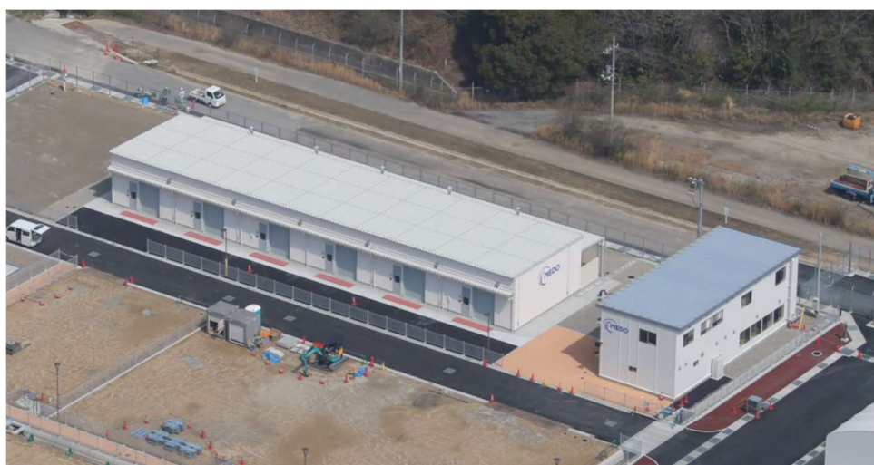
図 3.2.1.2-7 基礎先導拠点の竣工状況(2022年3月29日)
