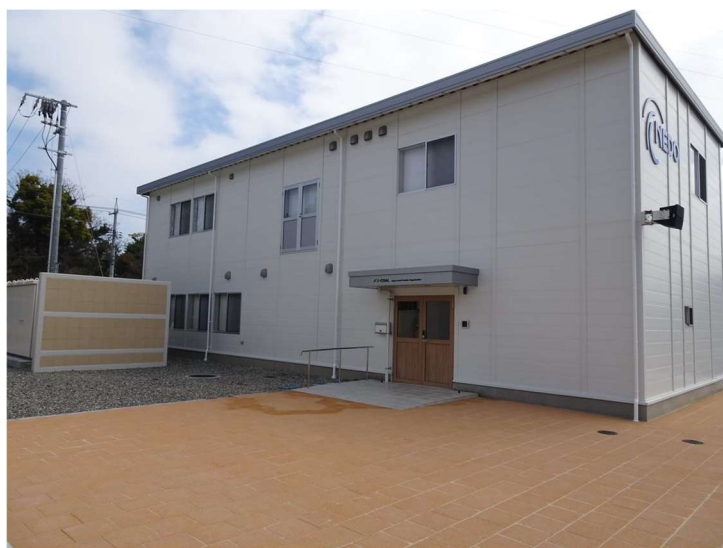
図 3.2.1.2-10 共用棟の竣工状況(2022年4月12日)
