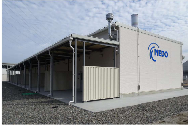
図 3.2.1.2-12 研究棟の竣工状況(背面側)(2022年3月29日)
