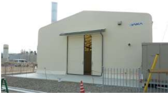
図 3.2.2.3-9 実証施設建物外観
