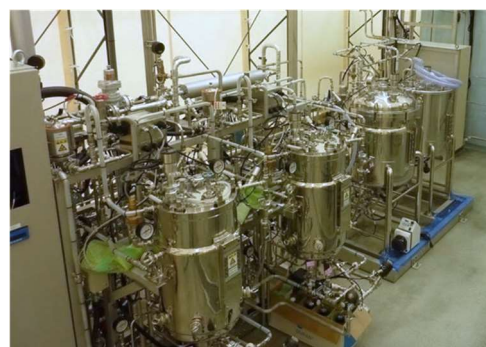
図 3.2.2.3-13 Gas-to-Lipids 一貫製造プロセス 手前から2連油脂発酵槽、酢酸貯留槽、廃液槽
