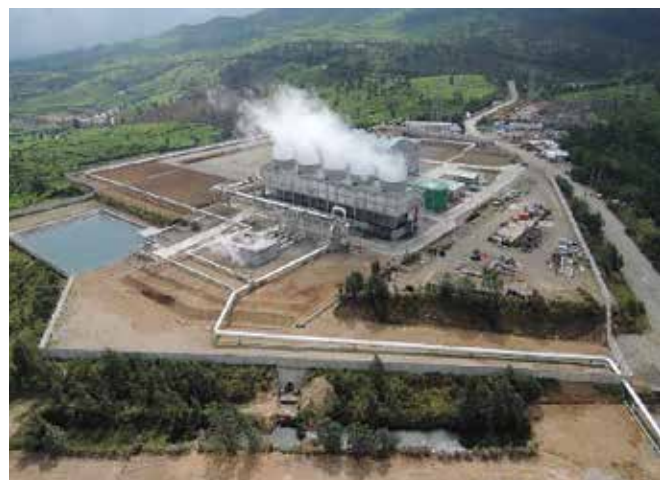
バトバ地熱発電所(インドネシア) 提供:東芝エネルギーシステムズ(株)
