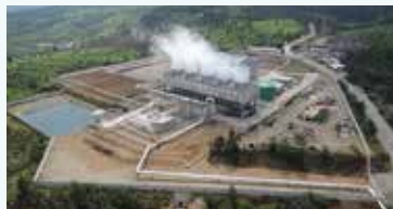
バトハ地熱発電所(インドネシア)
