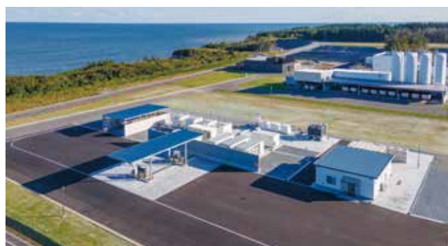
完成した「福島水素充填技術研究センター」
