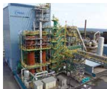
COURSE50試験高炉 提供：日本製鉄(株)
