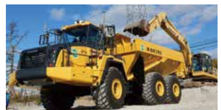
大型ダンプトラックの自動土砂運搬の実証実験
