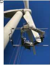
ブレード補修ゴンドラ
