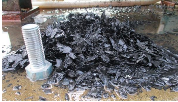
図Ⅲ-3 熱交換器に堆積した剥離スケール
