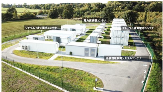
実証運転を開始した大規模ハイブリッド蓄電池システム
