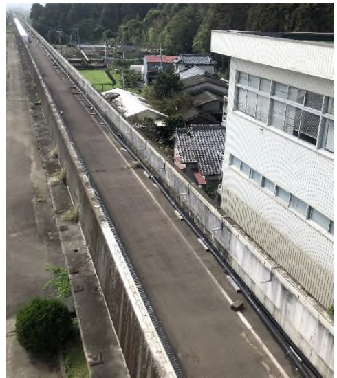
図 2.1.7-7 敷設した断熱管
