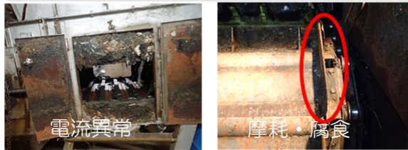
図 2.3.26 既設焼却施設の設備における発酵残渣受入の影響 (出所) 株式会社富士クリーン提供資料
