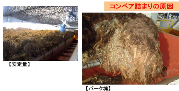
図 2.4.37 バークによる搬送コンベアトラブル
