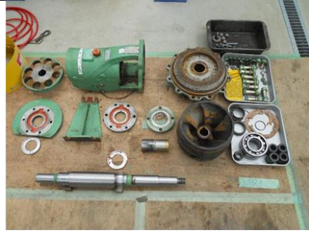
図 2.4.33 冷却水系統設備のメンテナンス状況
