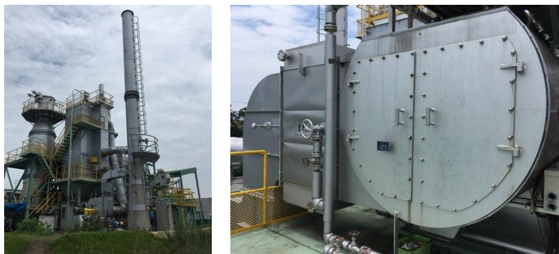
図 2.4.21 JFE 環境サービスの燃焼設備全景 (左)、ボイラー (エコマイザー側) (右)
