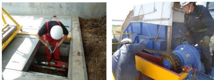
図 2.4.32 燃料搬送設備のメンテナンス状況
