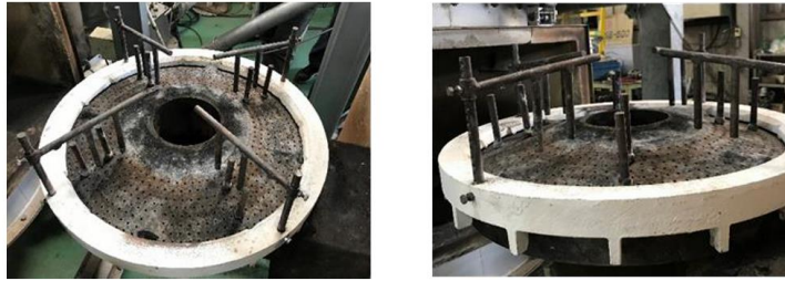
図 2.2.45 クリンカプレート設置状況
