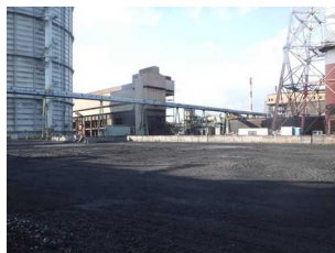
撤去工事後(更地)
