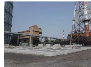
基礎工事(コンクリート4,600m3)
