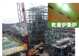
機器据付(機械重量7,000t)
