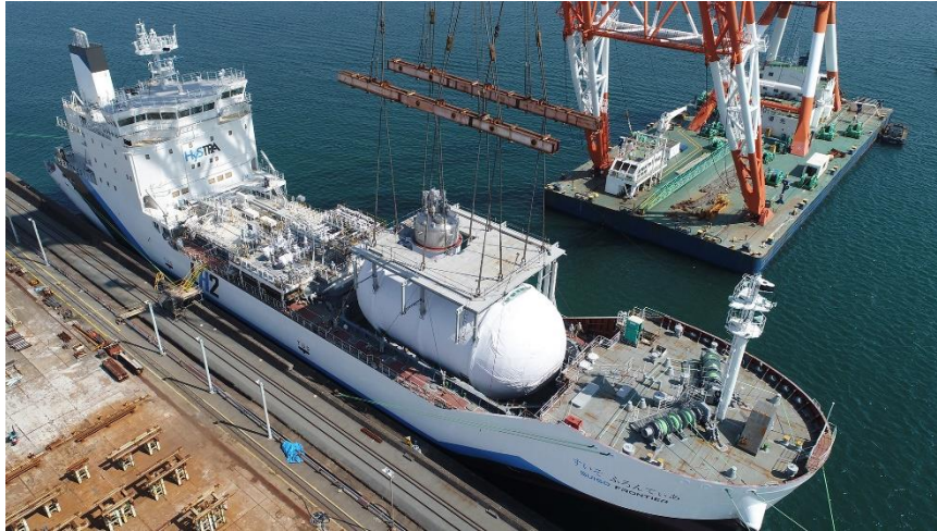
図 10 船体への本タンクシステム搭載作業時の様子
