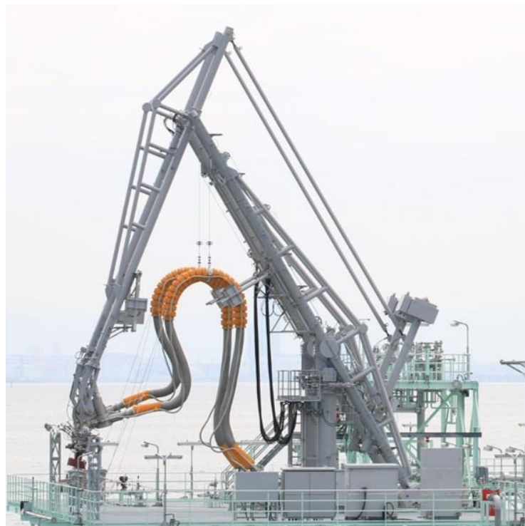
図 13 ローディングアーム据付等完了（2020年2月）
