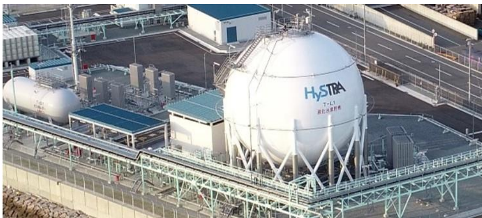
図 18 荷役基地建设完了（2020年8月）
