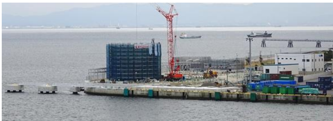
図 15 荷役基地建設状況 (2019 年 3 月現在)
