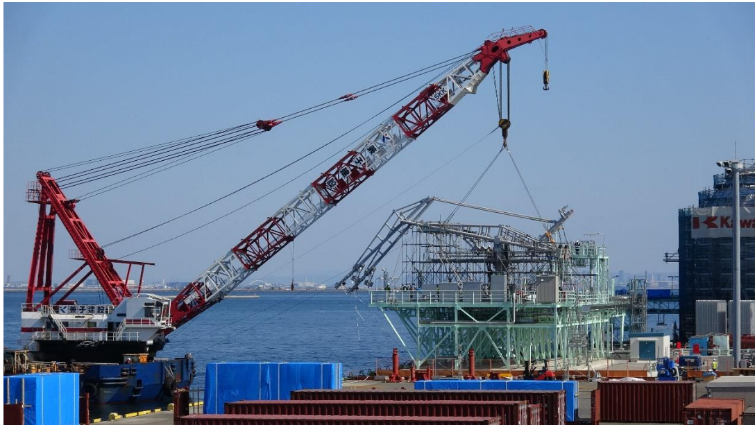
図 12 ローディングアーム現地据付の様子（2020年2月）
