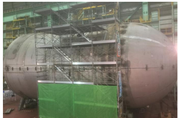
図7 外槽製作状況
