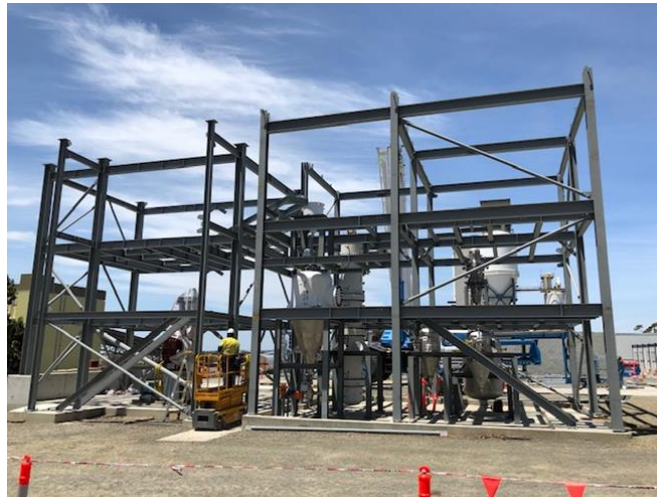
図 25 小型ガス化試験設備 建設状況（2020年1月）
