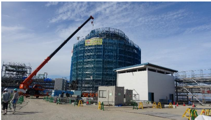
(a) 液化水素貯蔵タンク
