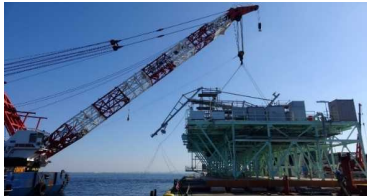
ローディングアームシステム現地据付状況①
