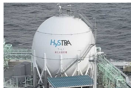
液化水素貯蔵タンク現地据付状況③
