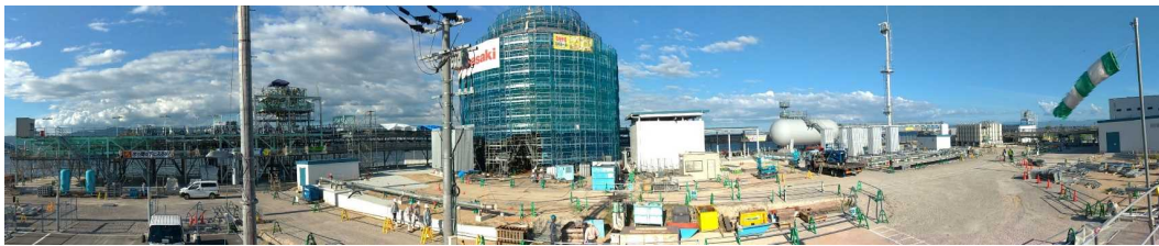
据付工事全景
