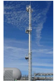
ベントスタック据付
