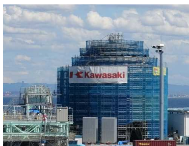
液化水素貯蔵タンク現地据付状況②
