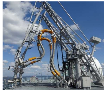
ローディングアームシステム現地据付状況②
