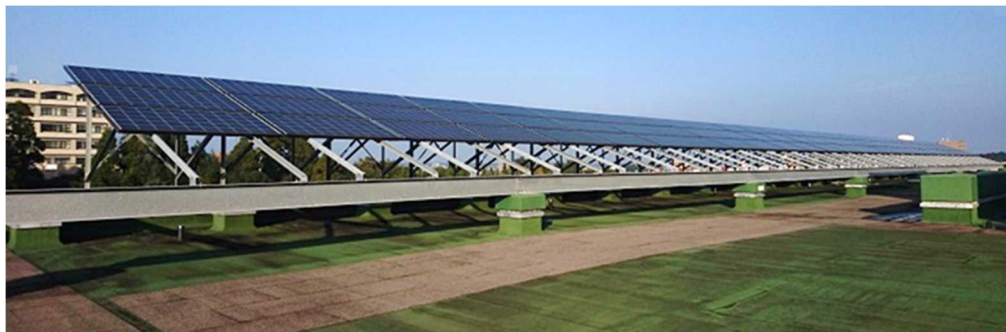
図Ⅲ-2-(ホ)-A-II-7 温度分布計測に使用した太陽電池アレイの写真 (モジュールサイズ: 1550 \text{ mm} \times 775 \text{ mm} 、アレイ: 縦 3 段 ( 2325 \text{ mm} ) \times 横 28 列 ( 43400 \text{ mm} ))
