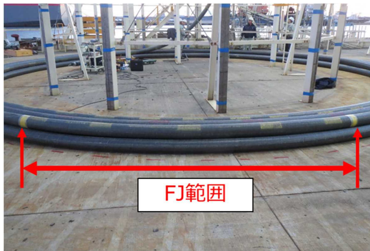
図 3-5-18 工場ジョイント外観
