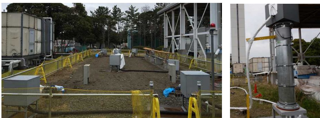
図 3-5-7 ケーブルを布設したフィールド
