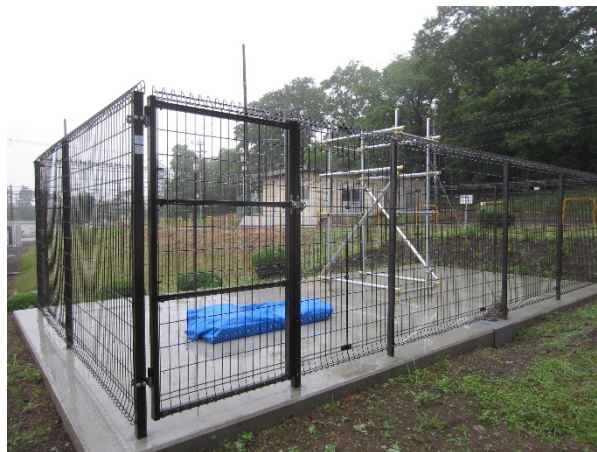
図 5.4(2)-16 実証試験用コンクリート基礎(43 地点)
