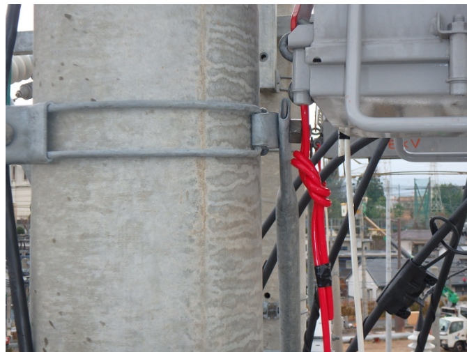
図 5.4(3)-7 開閉器操作網とアームタイバンドの干渉(上左図の矢印方向からの写真)
