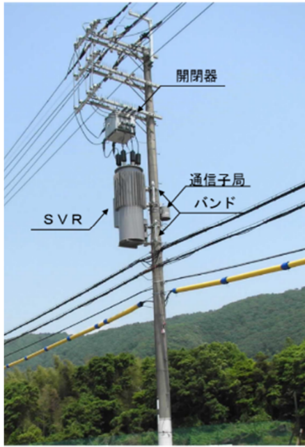
装柱状況 形状・寸法 図 5.4(3)-2 関西電力の SVR の装柱状況と形状・寸法
