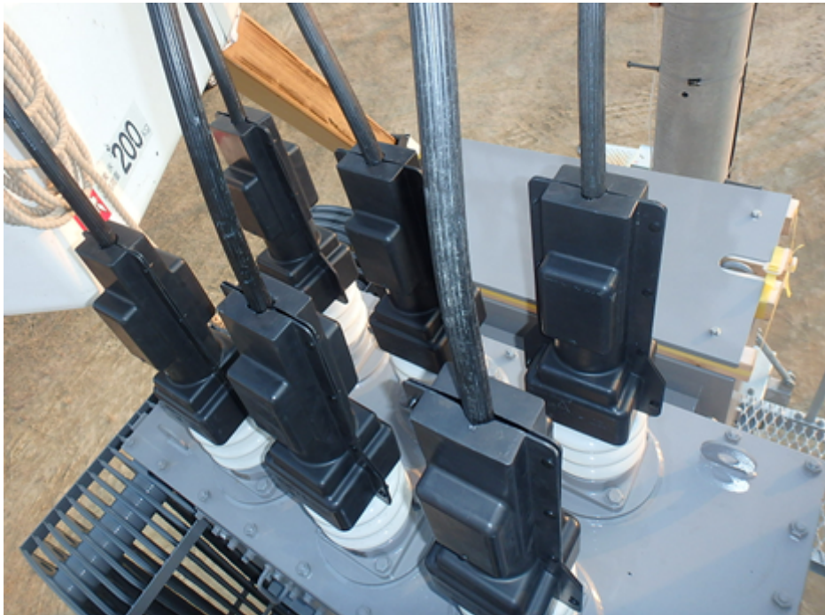
図 5.4(3)-4 次世代 TVR 専用端子カバーの取付
