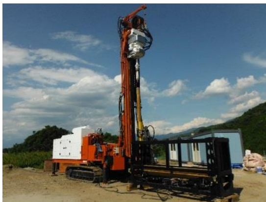
写真Ⅲ (1.2)-1 掘削機
